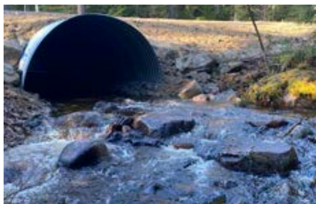
Figur 78. Nylagd valvbåge som inte utgör något vandringshinder. Stora Enso har ett omfattande program för att byta ut felaktigt lagda vägtrummor som utgör vandringshinder till valvbågar. Foto: Mark Jamieson.
